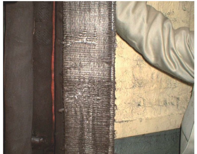
Bild 3-2: Prüfung durch einen Sachkundigen, Beispiel 2
